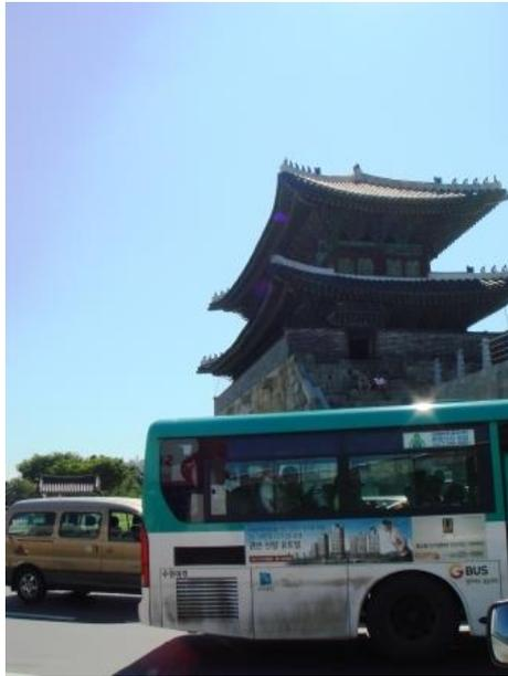
城壁の長さは、5km を越え、中国から西洋築城技術を輸入し、東洋と西洋の技術を融合させている。城郭の築造に石材とレンガが併用されている点が特徴的だ。
